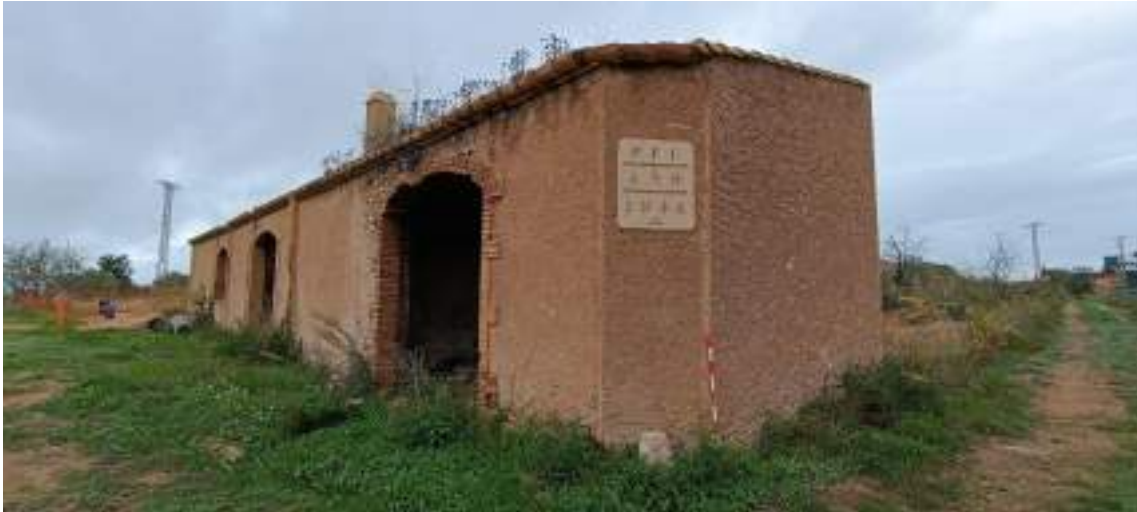
Mostra fotogràfica del rebaix observat a l'extrem E inferior de la parcel·la d. Imatge inferior edifici del 1944 RP7P9'24-6.
