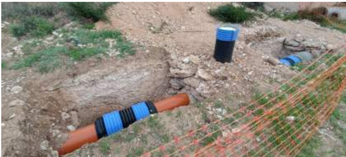
Mostra fotogràfica de les rases observades a l'àrea pròxima a l'edifici RP7P9'24-6
